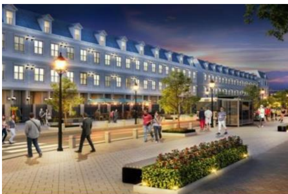
Hạ tầng khu Shophouse Harbor City - Sonasea Vân Đồn - QN
